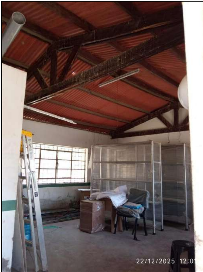
Imagen 03: Interior de Oficina administrativa.
