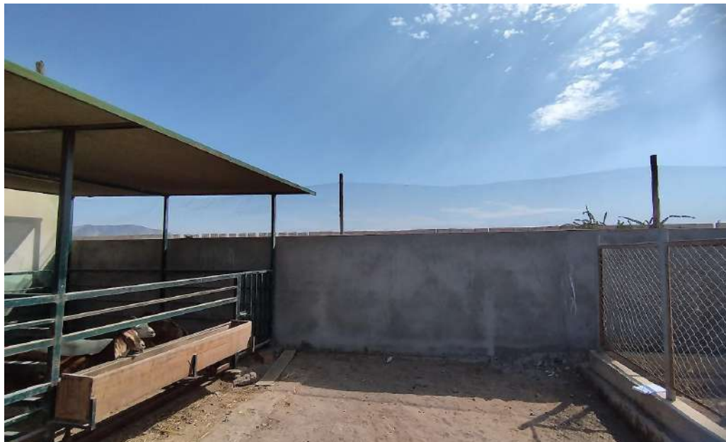
Imagen 04: Vista del fondo del área de corrales, se observa el muro perimétrico de menor altura.
