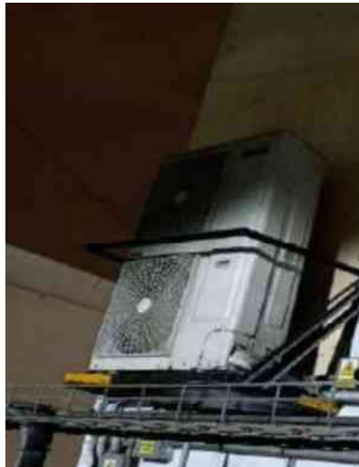
Imagen N°01.- Vista del equipo a desmontar.
