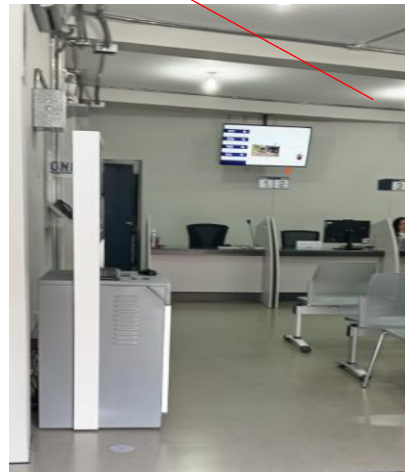
MURO DRYWALL A DESMONTAR
