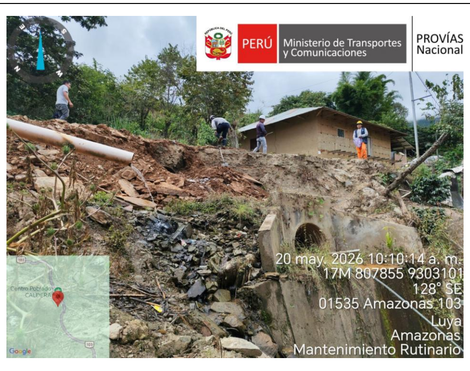
ASENTAMIENTO DE PLATAFORMA KM 190+920 AL KM 190+965 – PE-05NG (L=45m)
