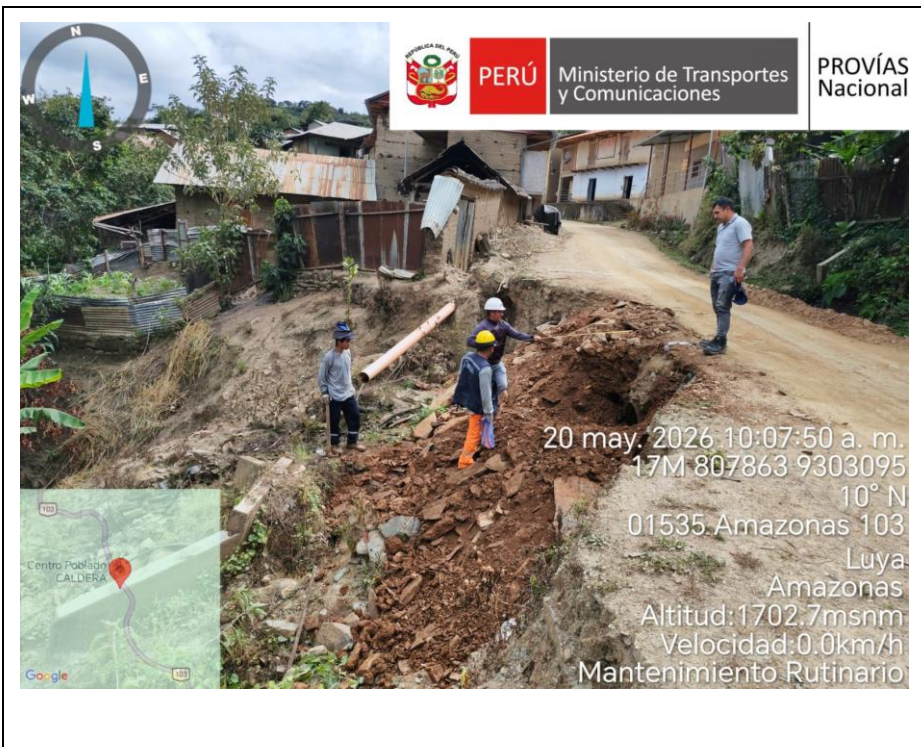
ASENTAMIENTO DE PLATAFORMA KM 190+920 AL KM 190+965 – PE-05NG (L=45m)
