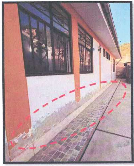
Fotografía N°5 Desprendimiento del contrazócalos exterior e interior y desintegración del acabado por una severa proliferación de humedad y hongos en la base del muro.
