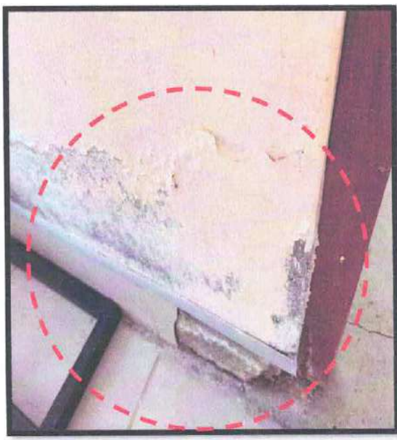
Fotografía N°5 Desprendimiento del contrazócalos exterior e interior y desintegración del acabado por una severa proliferación de humedad y hongos en la base del muro.
