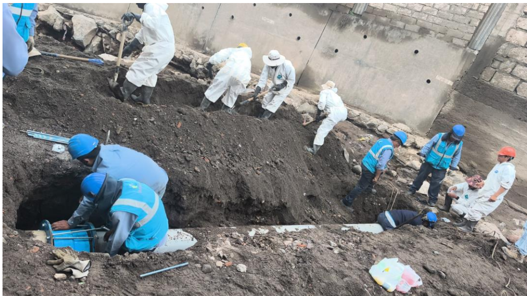
Ilustración 2. Reparación de tubería
