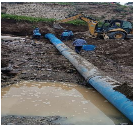
Imagen 2: Reposición de tubería
