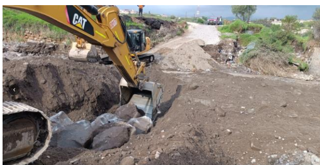
Imagen 3: Trabajos provisionales de protección a la tubería
