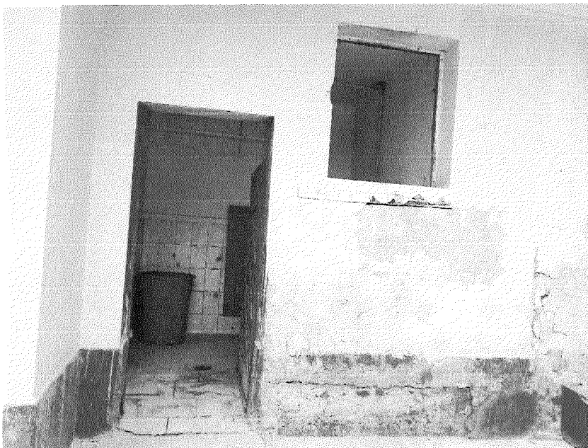
INGRESO SS.HH. DE DAMAS
