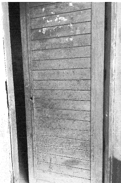
PUERTA DE SS. HH. DE VARONES
