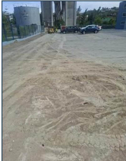
Imagen 03: Imagen estado actual
