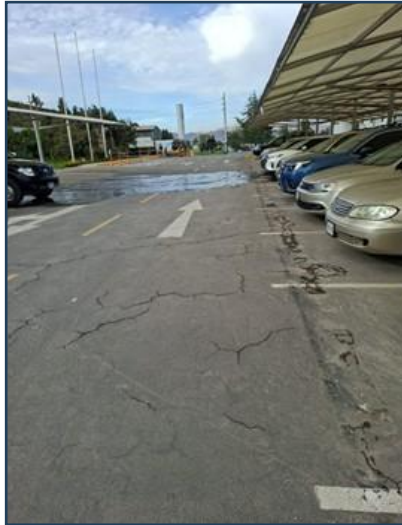
Imagen 09: Imagen estado actual
