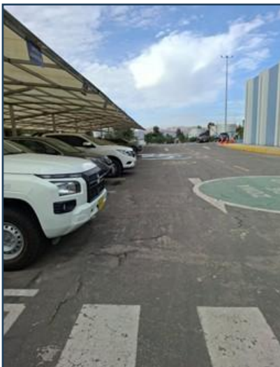
Imagen 11: Imagen estado actual
