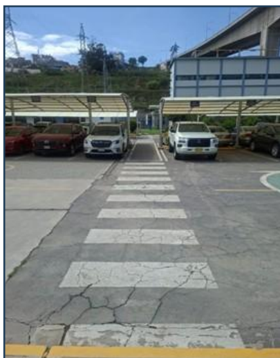
Imagen 01: Imagen estado actual
