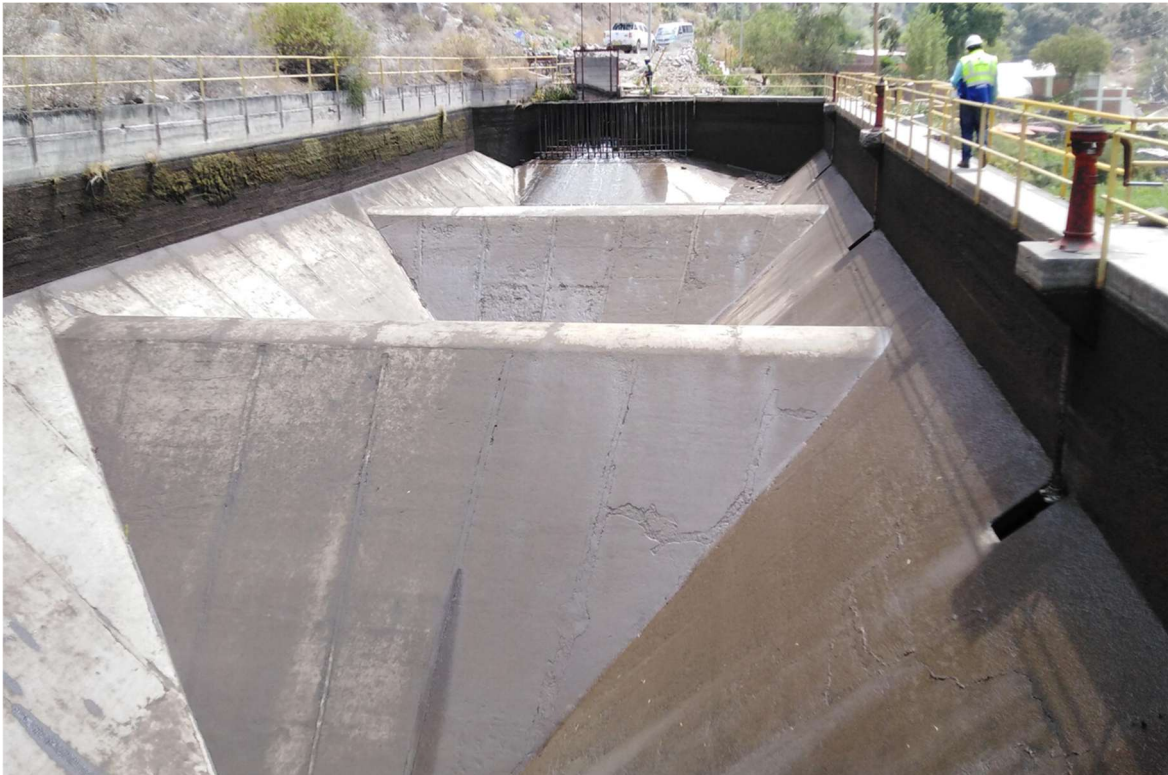
Imagen N° 2: Vista interna del desarenador el cual hace su limpieza de manera continua durante su operación al ser de purga continua.
