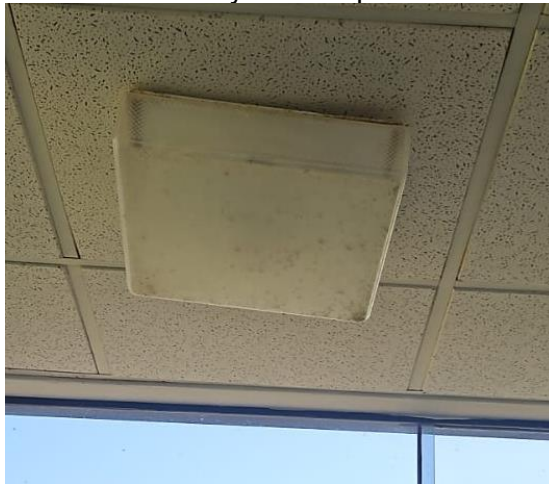
Limpieza de paneles de baños damas y varones sala de recepción
