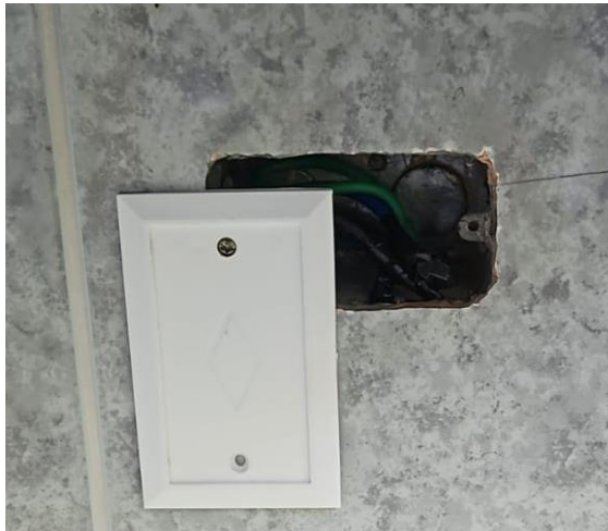
Instalación de tomacorriente y realizar pruebas de funcionamiento
