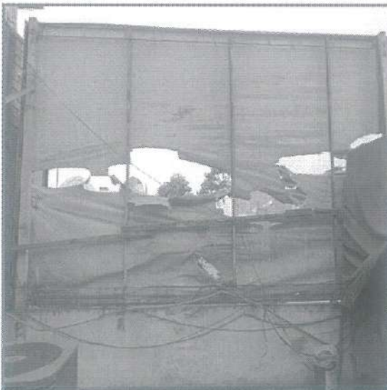
IMAGEN N° 3: En la Av. Grau, la infraestructura publicitaria se encuentra en mal estado, con ruptura del panel.
