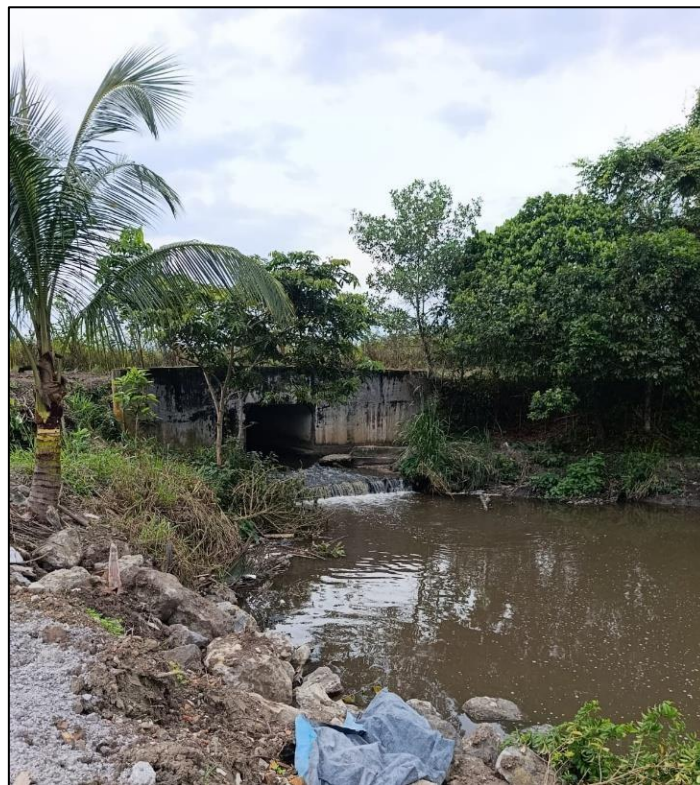
Figura N° 04: Alcantarilla y cuerpo de agua superficial en el área de ampliación
