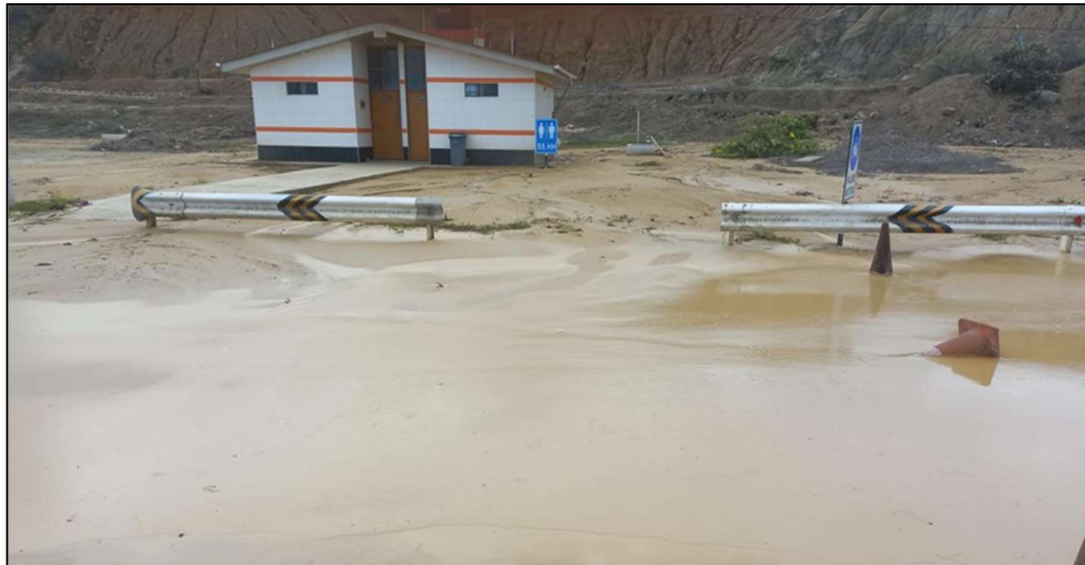
Colmatación de lodos en el exterior del baño público.
