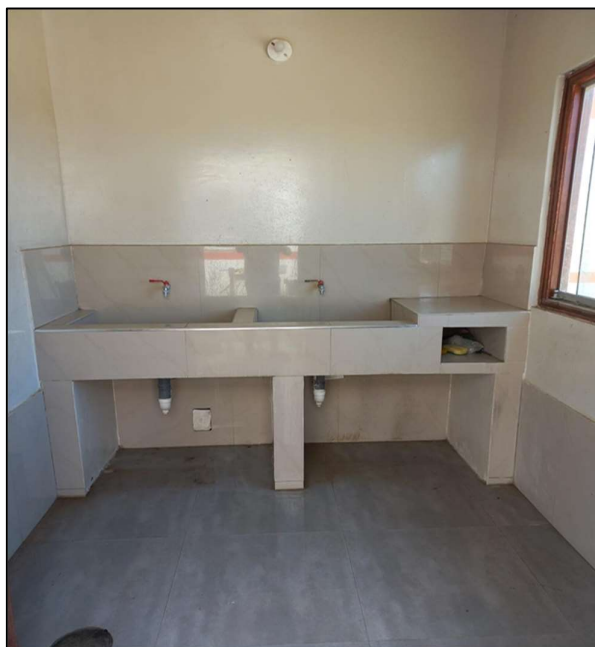
Vista Interior del lavatorio multiusuario.
