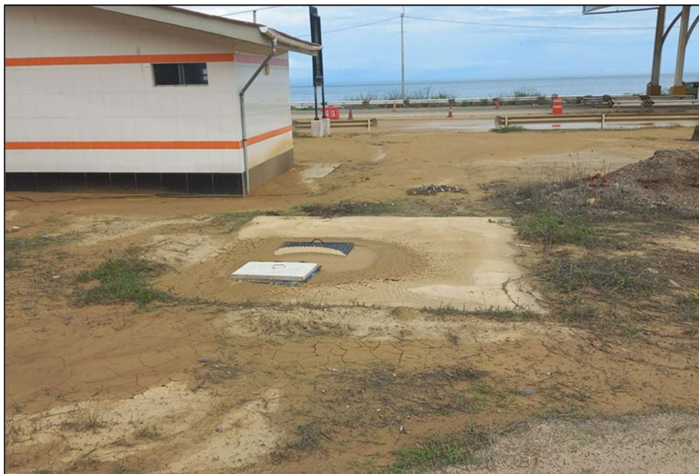
Vista del exterior de la tapa del tanque cisterna enterrado de polietileno de 5000 litros.
