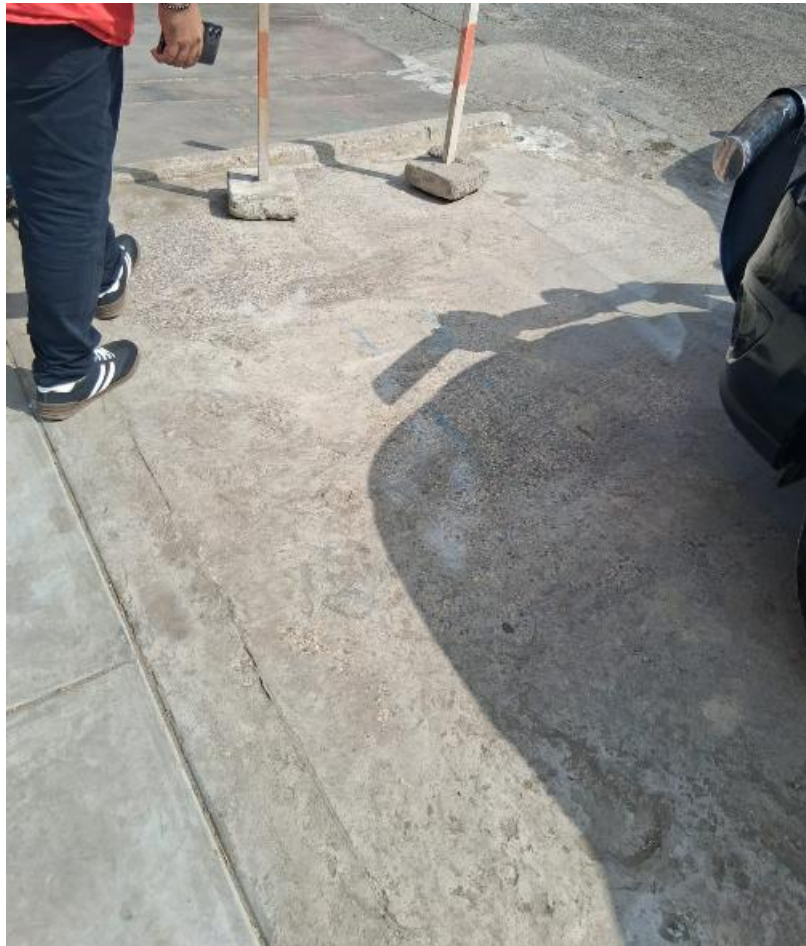
Imagen referencial N°2: Estado actual del piso terrazo
