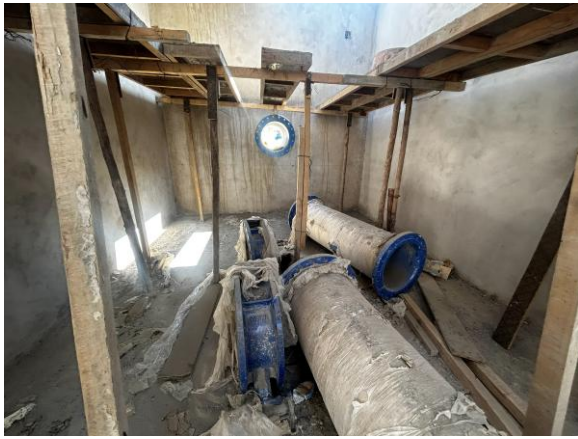
Ubicación propuesta de medidores de caudal al interior de la cámara
