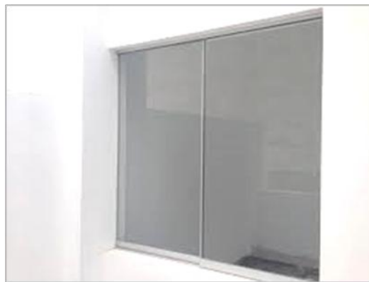
Figura N° 03: Imagen referencial de ventana de aluminio tipo corrediza con sistema NOVA
