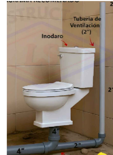
Imagen referencial Salida de tubería de ventilación
