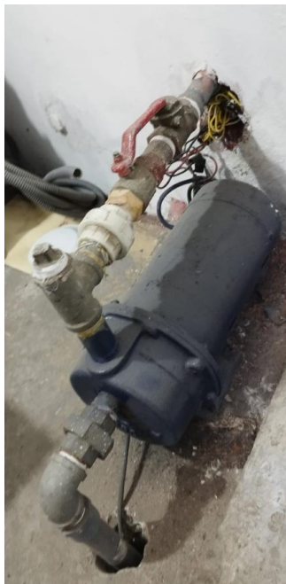
Imágenes 09 y 10: electrobomba de impulsión existente
