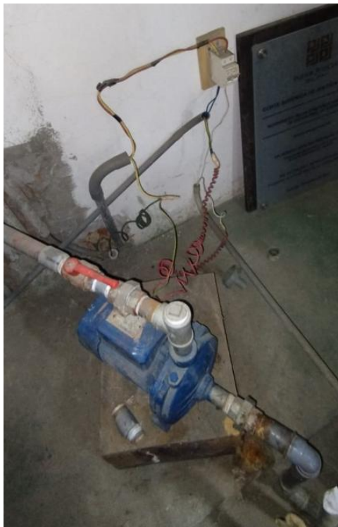
Imágenes 14 y 15: electrobomba de impulsión existente
