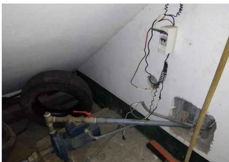
Imágenes 12 y 13: electrobomba de impulsión existente
