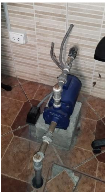
Imágenes 03, 04 y 05: electrobomba de impulsión existente
