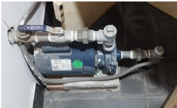
Imágenes 01 y 02: electrobomba de impulsión existente
