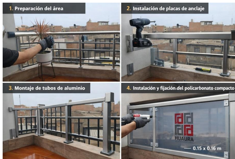
Figura N° 05: imagen referencial del procedimiento de instalación del policarbonato en el segundo piso
