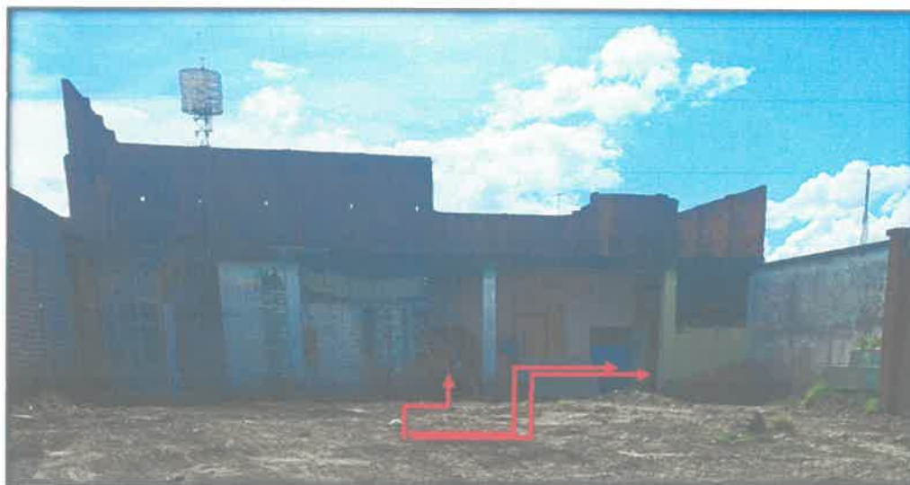
Imagen 08. Vista de puertas existentes
