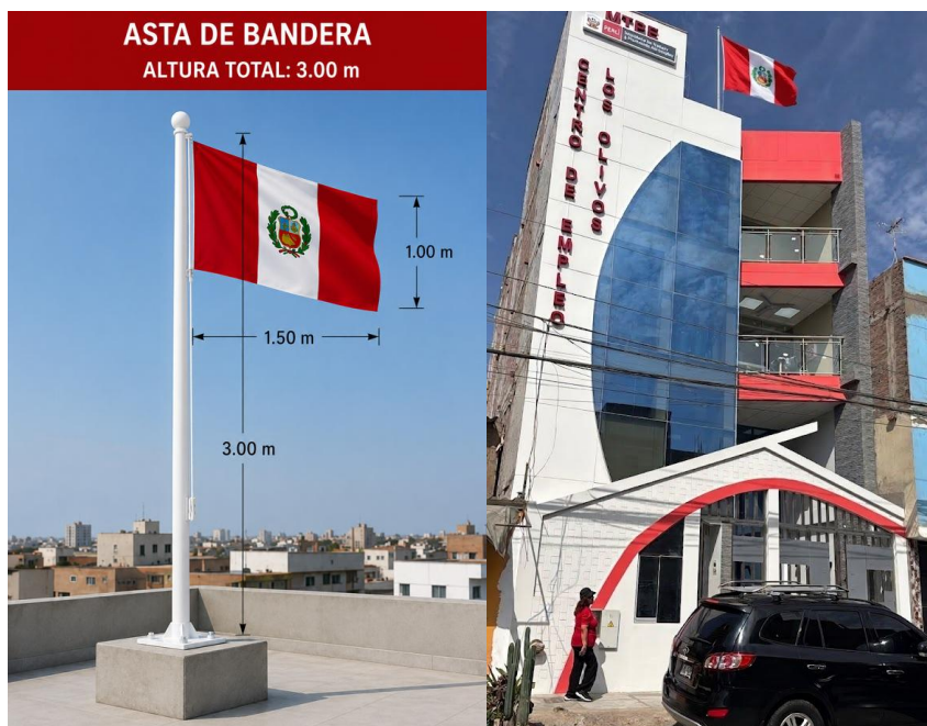
Imagen Referencial N°1: Ubicación del asta en la azotea
