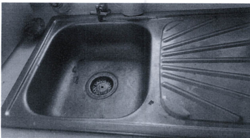
Imagen N° 01: Trabajos a realizar en la Cocina de la UP Chalhupquio.
