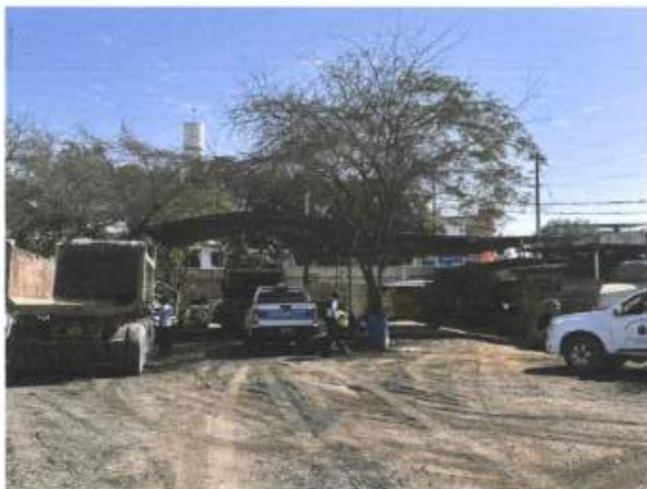
FIGURA 1: LA ADECUACION DE LOSA DE CONCRETO.
