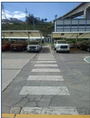
Imagen 01: Imagen estado actual
