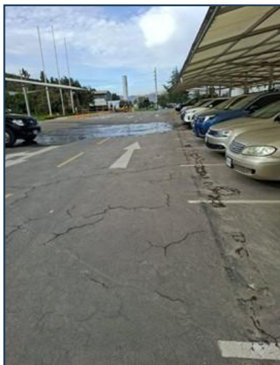
Imagen 11: Imagen estado actual
