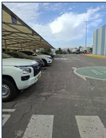
Imagen 13: Imagen estado actual
