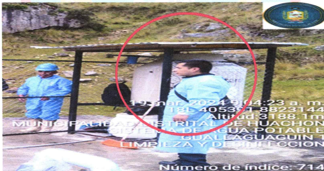
S190102004903 - GALLAGUAGUIN 1 ubicado en Quiparacra en el reservorio se ejecutara el servicio de limpieza y desinfección.
