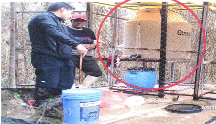
S190102004801 – SHISHUA ubicado en Quiparacra en el reservorio se ejecutara el servicio de limpieza y desinfección.
