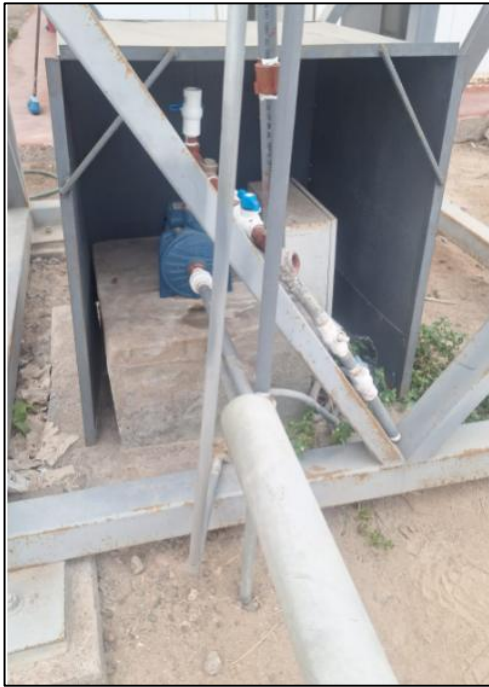
Vista del gabinete que alberga la electrobomba y su tablero de control
