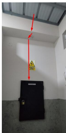
Pase por el ducto y llegada al tablero ubicado en el primer nivel, dentro de carceletas de damas.
