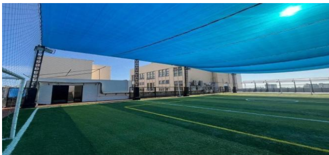
Imagen N°01 Malla rashell a retirar
