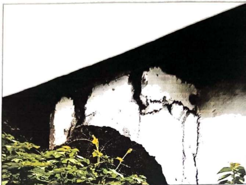
Imagen N° 10 muestra parte de la cobertura sin calamina y calaminas en peligro de caída
