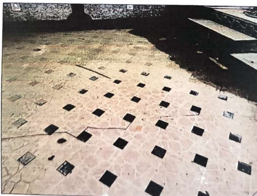
Imagen N° 06: muestra daños de rajaduras en el suelo por el humedecimiento.
