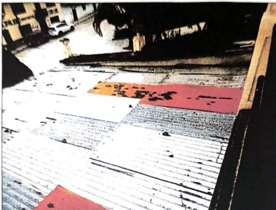
Imagen N° 04: muestra calaminas con peligro de caída
