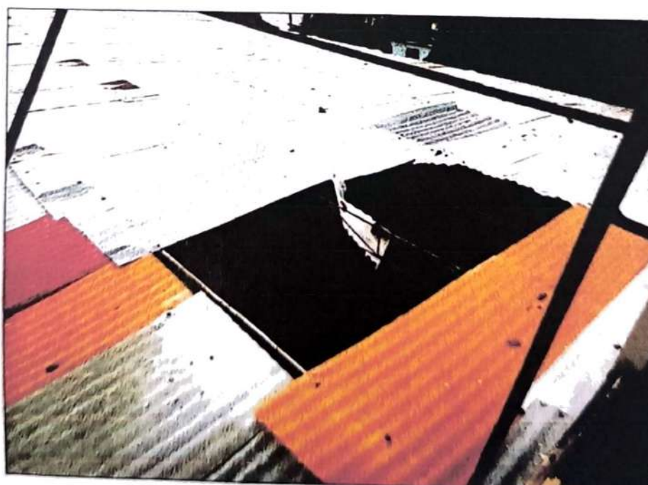
Imagen N° 02: muestra parte de la cobertura sin calaminas
