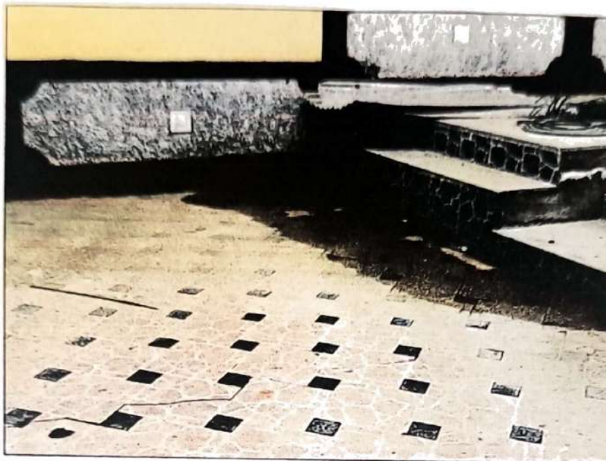
Imagen N° 06: muestra daños de rajaduras en el suelo por el humedecimiento.
