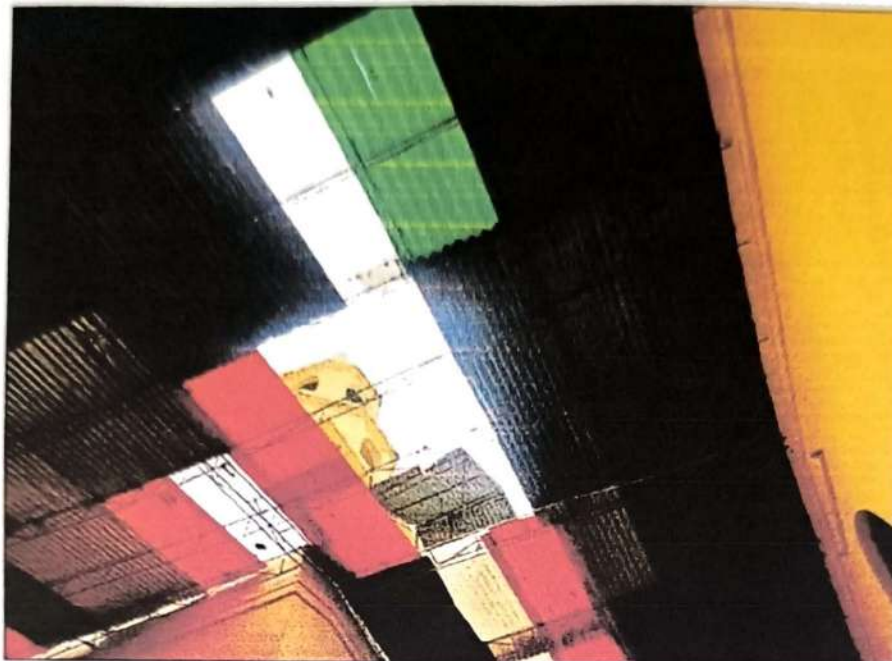
Imagen N° 08: muestra calamina con indicio de caída.
