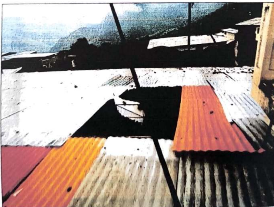
Imagen N° 04: muestra calaminas con peligro de caída
