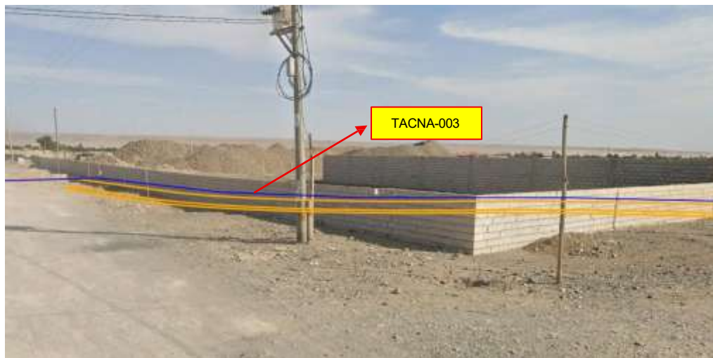
Vista Fotográfica 04: Muro del predio TACNA-003 a retirar y delimitar el derecho de vía.
