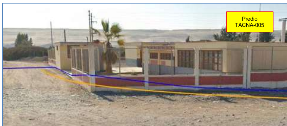
Vista Fotográfica 01: Muro del predio TACNA-005
