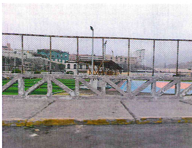
RESANE DE BARANDAS DE CONCRETO
