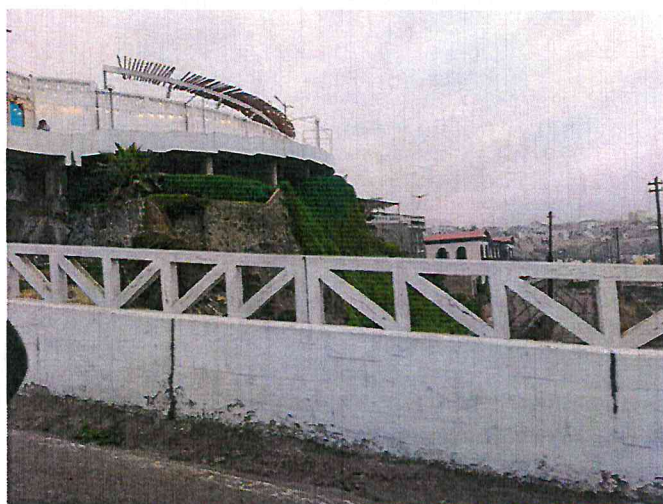
RESANE DE BARANDAS DE CONCRETO
