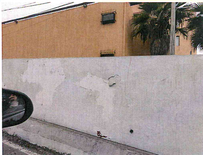
LIJADO Y PINTADO DE BARANDAS DE CONCRETO
