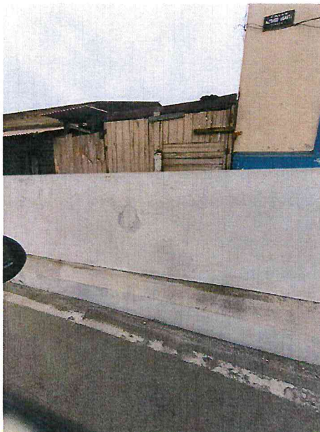
PINTADO DE BARANDAS UBICADAS EN LOS ACCESOS AL CIRCUITOS DE PLAYAS ASI COMO LA SEÑALIZACION HORIZONTAL VEHICULAR CON PINTURA TRÁFICO
