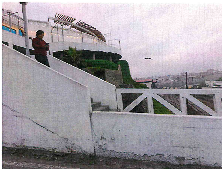
PINTADO DE BARANDAS DE CONCRETO
