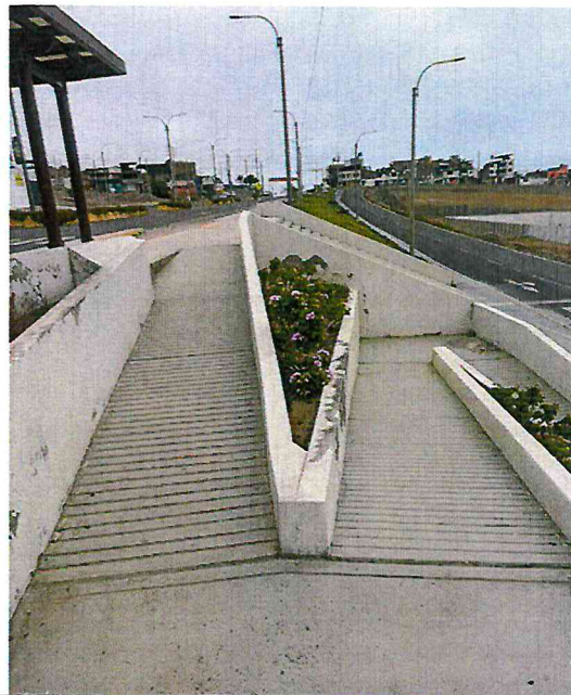
INFRAESTRUCTURA VIAL EXISTENTE SECTOR APIAMO – PINTADO DE BARANDAS DE CONCRETO
