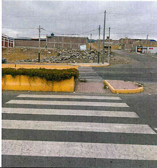
INFRAESTRUCTURA VIAL EXISTENTE SECTOR APIAMO – PINTADO DE SEÑALIZACION HORIZONTALES
