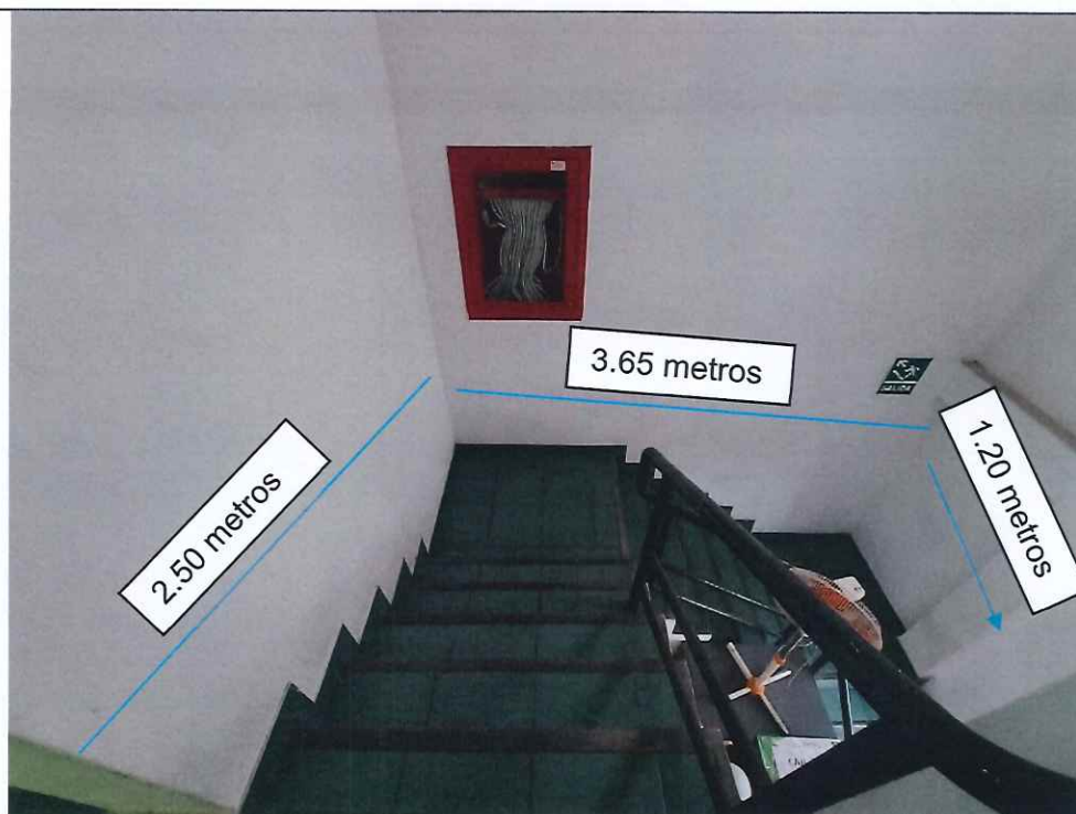
Área de trabajo (foto actual)
