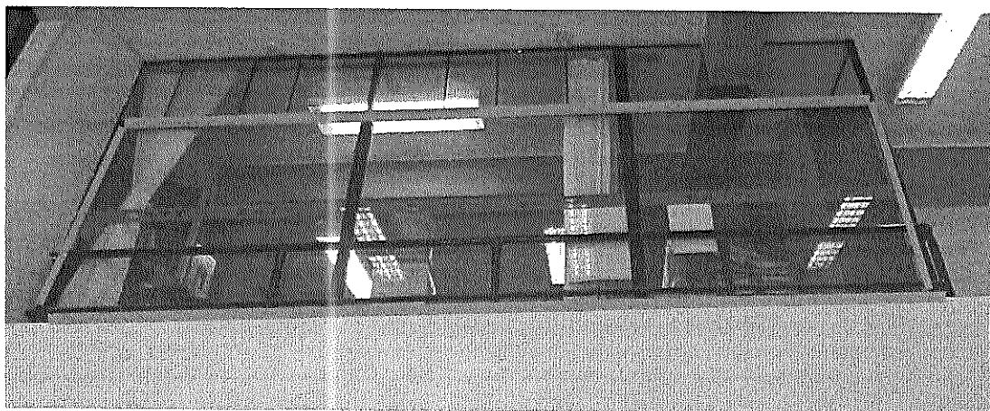
Instalación de las 03 laminas empavonadas (foto actual)
