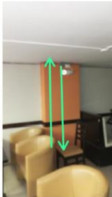
Imagen 12: Falsa columna por donde pasan las tuberías de desagüe y de ventilación , ubicadas en el piso 1 y mezzanine.
