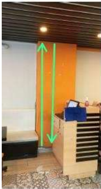
Imagen 12: Falsa columna por donde pasan las tuberías de desagüe y de ventilación , ubicadas en el piso 1 y mezzanine.
