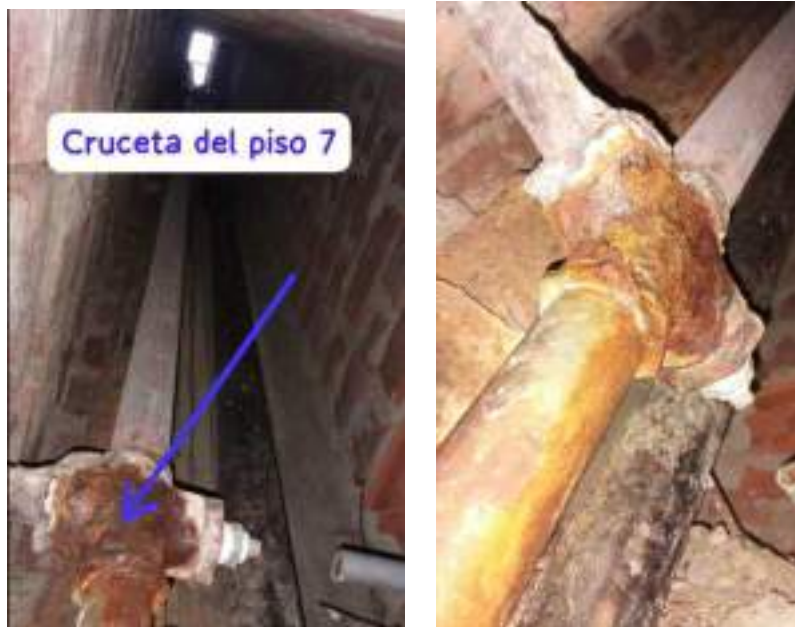
Imagen 4: Empalme de tubería montante de agua de F°G° de Ø 2" con tubería de distribución de baño y cocina en cada piso ( uno en cada lado).
