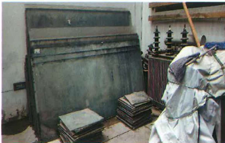
Foto N°01: Material y elementos de vidrio inservibles.
