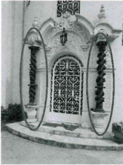
Columnas de Madera existente
