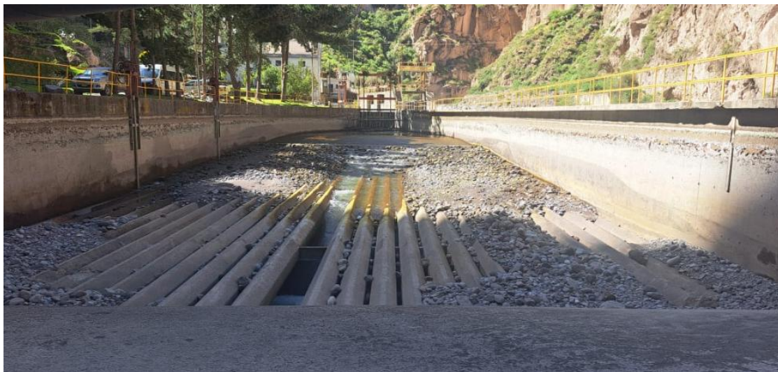
Imagen 1. Desarenador de Charcani VI – Nivel superficial.
