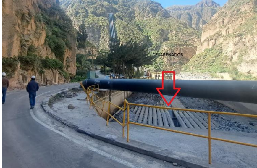
Imagen 2. Vista de desarenador – desniveles.
