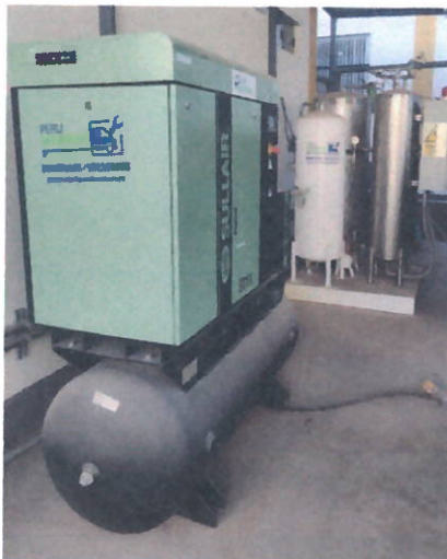
IMÁGENES DE PLANTA DE OXÍGENO DE 5 M3/H
