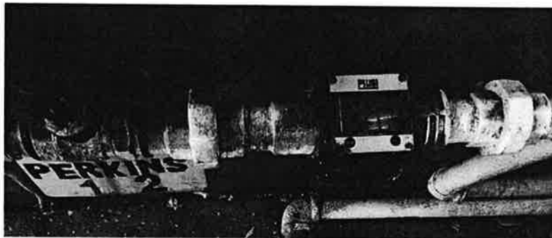
Medidor N° 3: Atico - Medidor entrada grupo electrógeno, para Perkins 1 y Perkins 2 (de 1")
