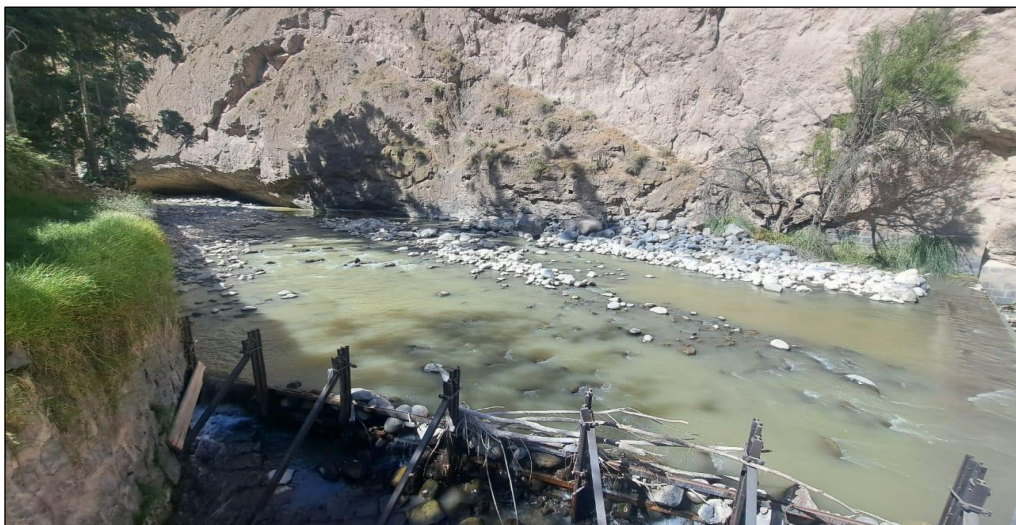
Imagen 1. Zona para encauzamiento de río y limpieza de barraje.
