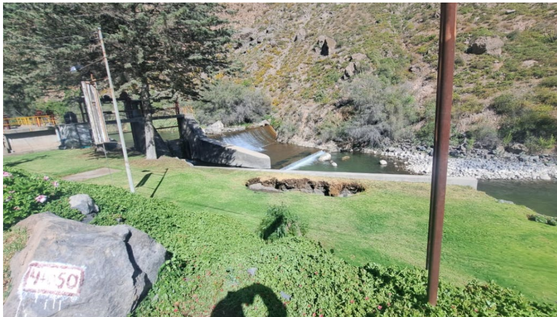
Imagen 1. Captación de Charcani III.
