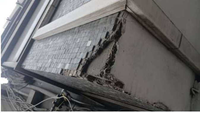
Zonas del enchape con pepelma que presentan desprendimientos o pérdida de piezas
