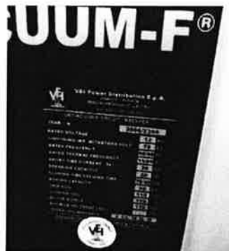
Datos de placa del interruptor montado en celda de 10kV
