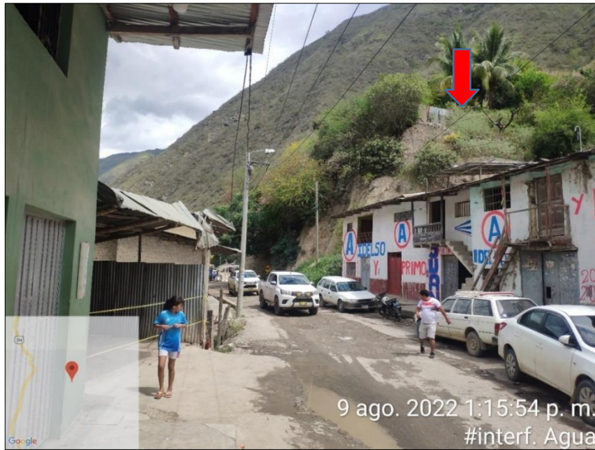
Imagen N° 8. Reservoirio Existente V=25 m3
