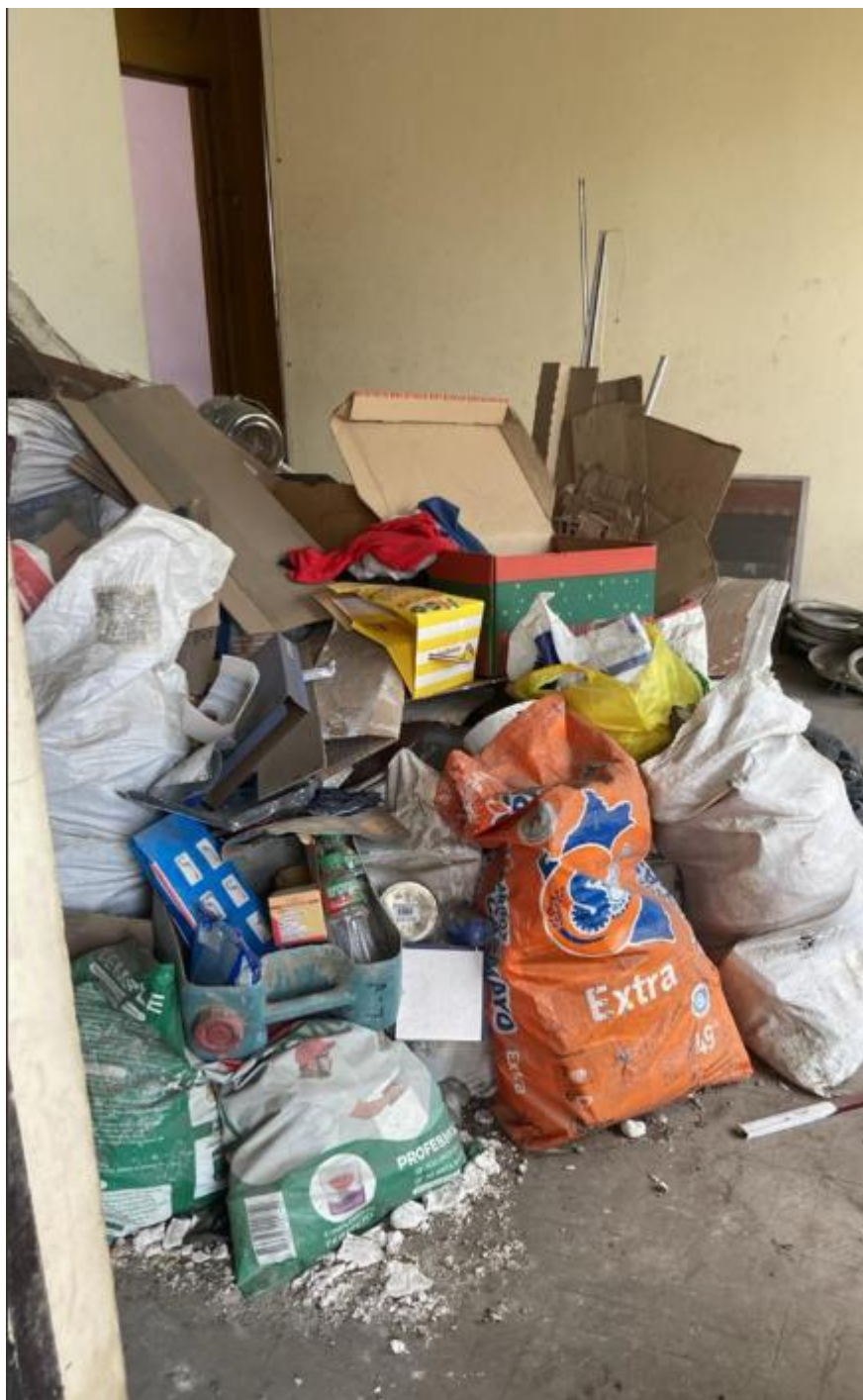
Imagen N° 7.- Desmote, escombros y elementos en desuso ubicados en el inmueble denominado 28 de Julio, bloque B
