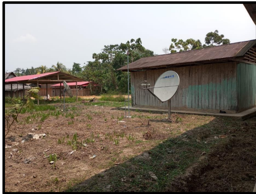
FIGURA N° 01: ÁREA EN DONDE INSTALAR ARMAZONES Y PANELES
